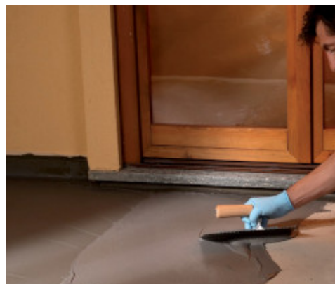
Impermeabilização de terraço com espátula
