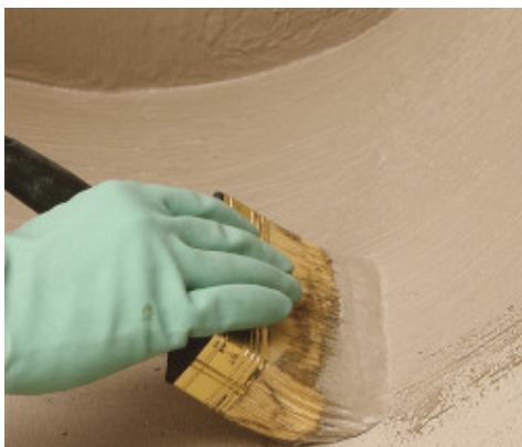
Impermeabilização de detalhes a pincel
